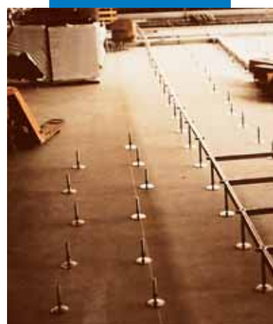
Laje nivelada com Ultraplan para aplicação de pavimento flutuante
