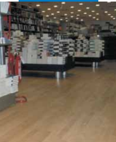
Exemplo de assentamento de madeira realizado sobre regularização em Ultraplan - Messagerie Musicali - Roma - Itália
