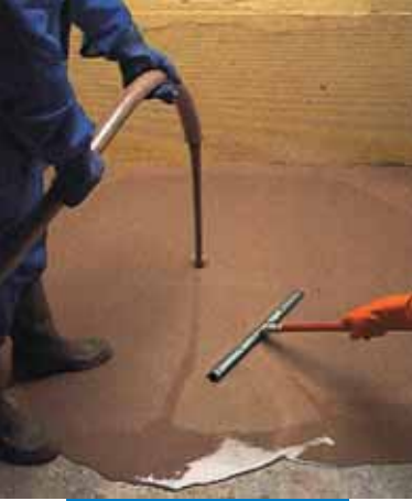
Aplicação do Ultraplan com bomba e passagem com rodo
