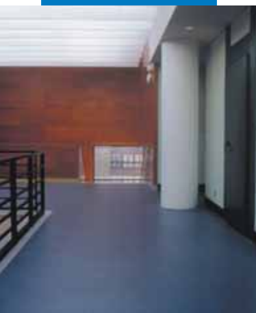
Exemplo de assentamento de linóleo realizado sobre regularização em Ultraplan - Conservatório de Monzón - Espanha
