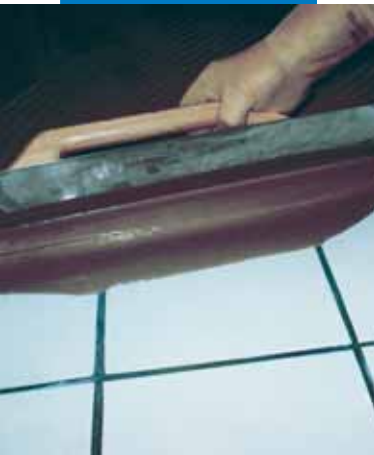
Aplicação do Ultraplan com espátula metálica sobre pavimento preexistente em cerâmica previamente tratado com Mapeprim SP
